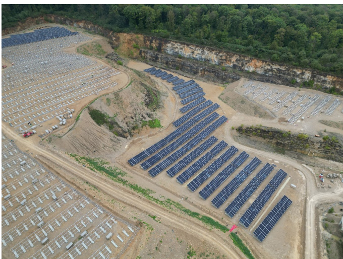
Pose de modules
