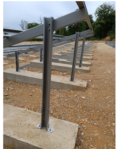
Montage des structures
