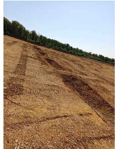
Création des noues
